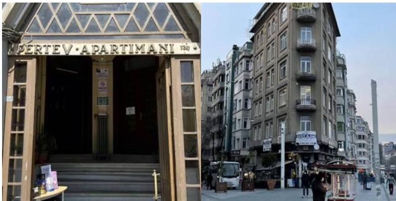
Şekil 16: Pertev Apartmanı, Taksim, Beyoğlu, Art Deco örneği
